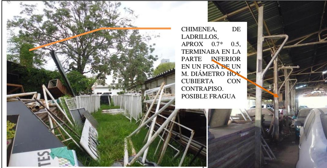
CHIMENEA, DE LADRILLOS, APROX 0.7\* 0.5, TERMINABA EN LA PARTE INFERIOR EN UN FOSA DE UN M. DIÁMETRO HOY CUBIERTA CON CONTRAPISO. POSIBLE FRAGUA
