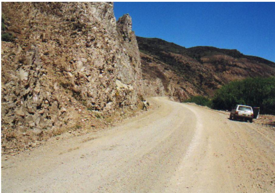
Foto 29: Corte en vulcanitas fracturadas con planos inclinando hacia la ruta.
