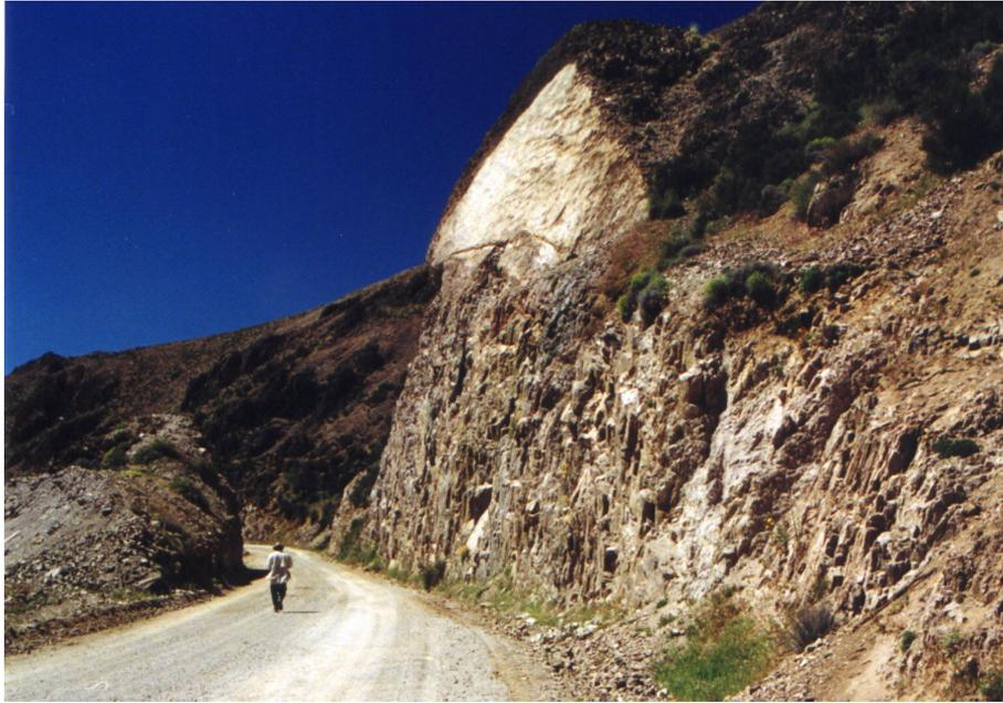
Foto 30: Sector de corte encajonado en rocas tipo III.
