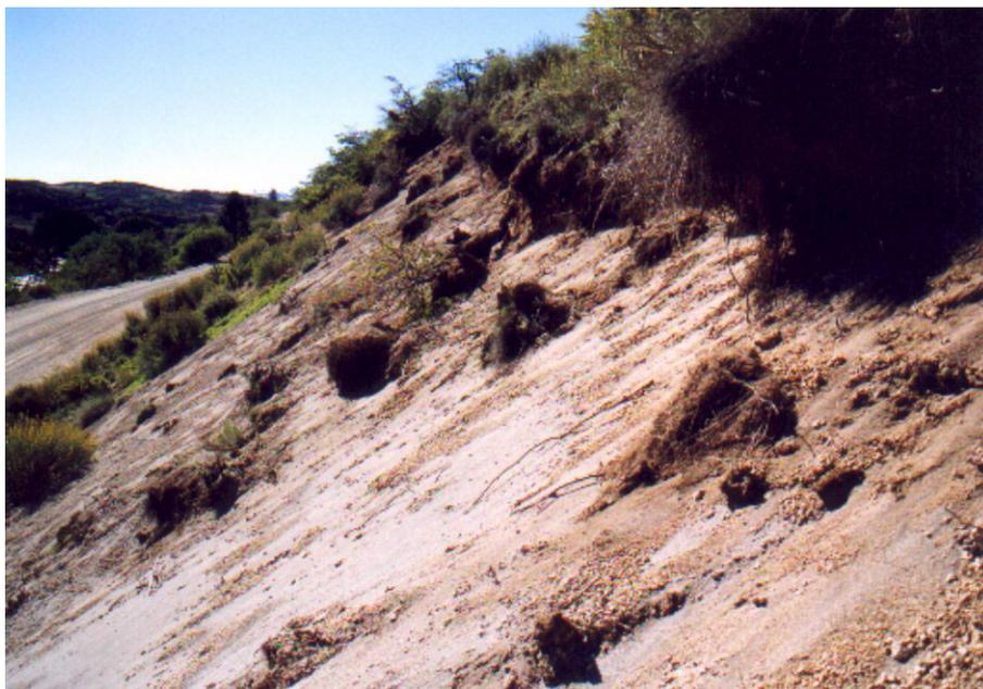
Foto 62: Vista de talud en tefras afectado por reptaje, afectando al suelo vegetal superior, que se desliza en bloques.
