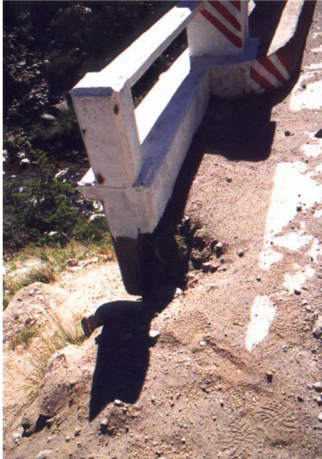
Foto 61: Erosión del terraplén de avance en el contacto con estructura de hormigón.
