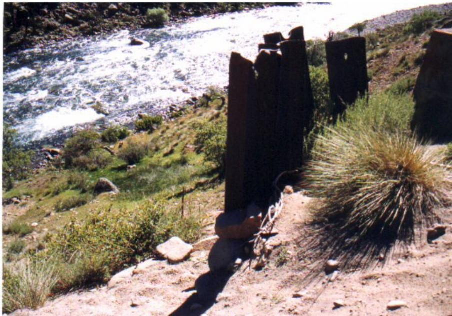
Foto 59: Vista de erosión al pie del tablestacado y vertiente al pie del talud.
