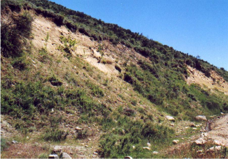
Foto 32: Corte en drift con erosión y depositación de materiales al pie, formando un talud de menor pendiente con vegetación.
