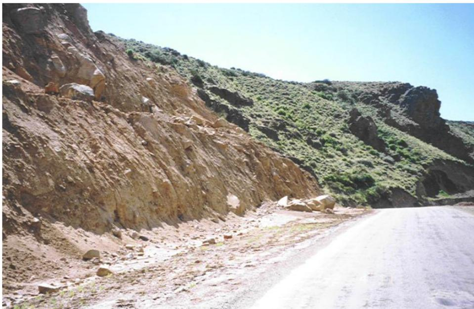
Foto 1: La forma inadecuada en que se cortaron los taludes de roca, en el tramo Rahue-Aluminé.
