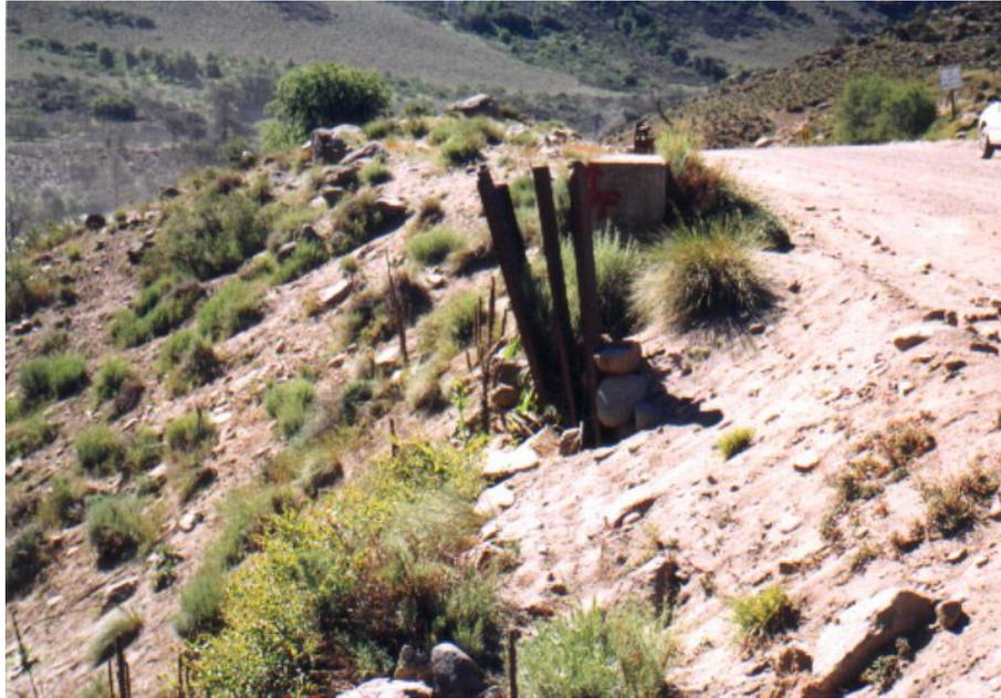
Foto 58: Vista del talud con muro de hormigón y tablestacado deteriorado.
