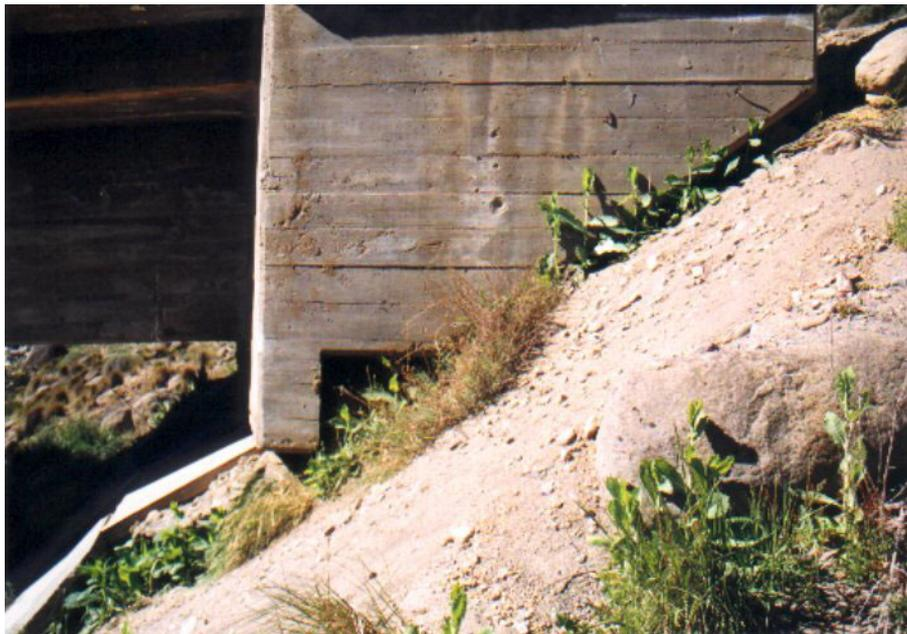
Foto 60: Vista de la estructura de hormigón descalzada por erosión del terraplén de avance en puente sobre arroyo Rebolledo.
