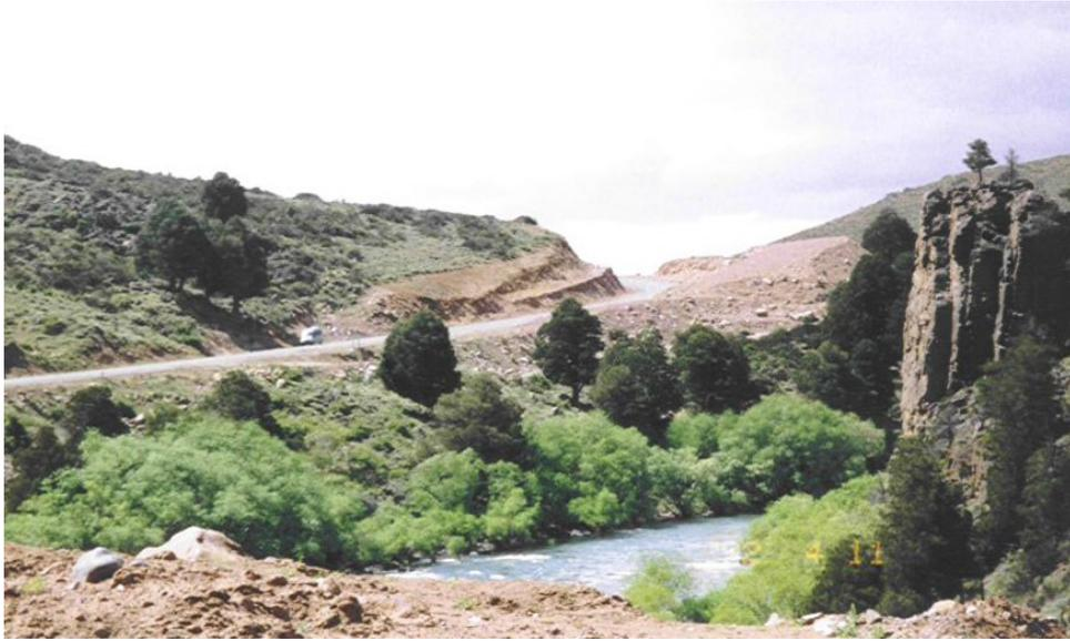
Foto 3: El elevado impacto visual de los cortes realizados al terreno y no revegetalizados
