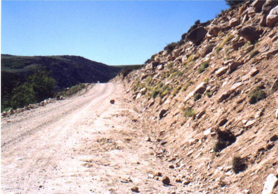
Foto 56: Vista del corte en sedimentos glaciares con caída de rodados sobre el camino.
