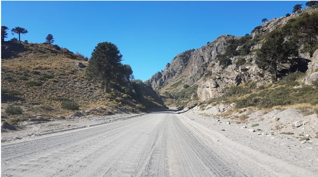
Foto 30- Km 13- Contrataludes a desmontar. Presencia de rocas en ambos laterales.
