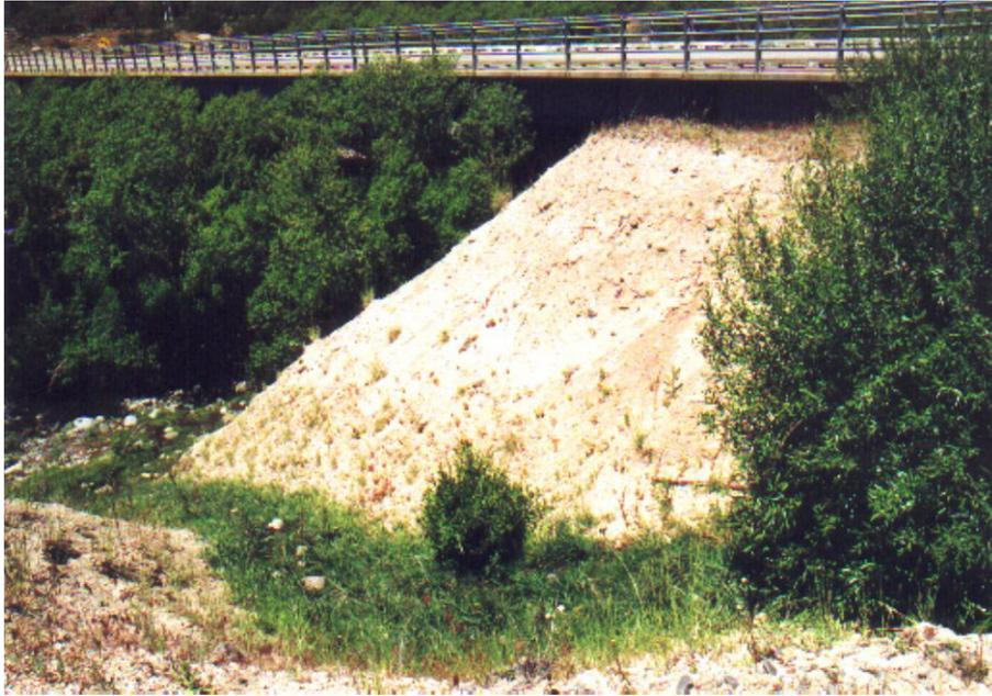
Foto 45: Vista de erosión por arroyo en terraplén de avance del puente La Querencia.
