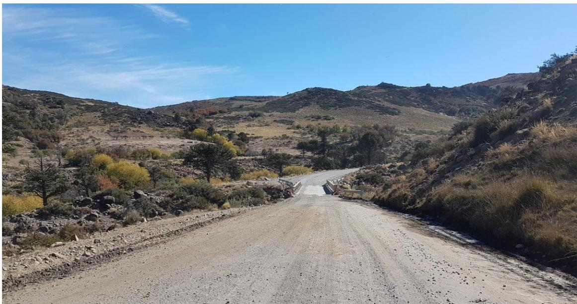
Foto 15- Km 5 - Puente sobre A° Rebolledo. Un solo carril de circulación. Ancho = 4 metros.
