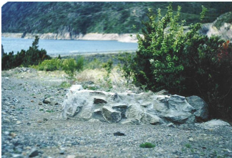
Foto 68: Cabezales de alcantarillas con muros construidos con rocas del lugar.
