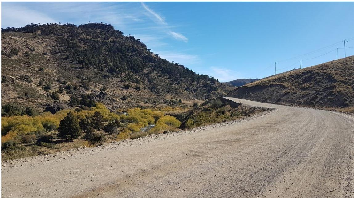
Foto 11- Km 1.5 Desmonte en lateral derecho (suelo en talud a estabilizar)
