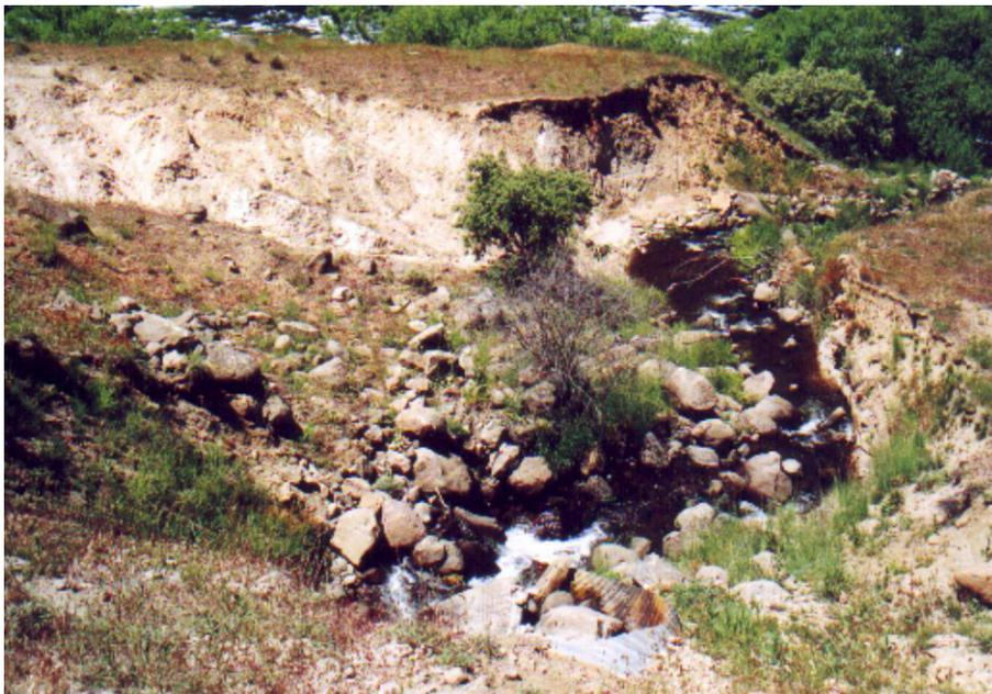
Foto 44: Erosión aguas abajo de la alcantarilla.
