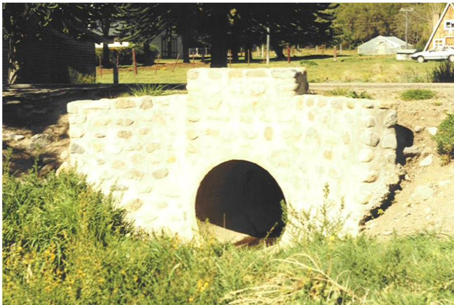
Foto 67: Cabezales de alcantarillas con muros construidos con rocas del lugar.
