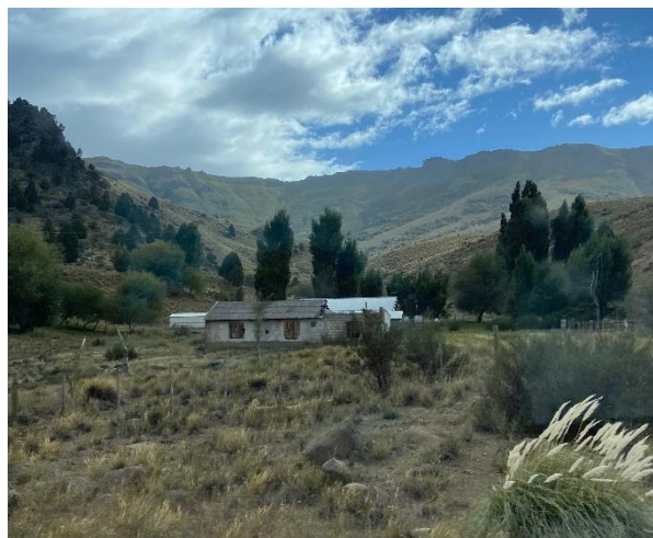
Viviendas ubicadas a los lados de la Ruta N° 23
